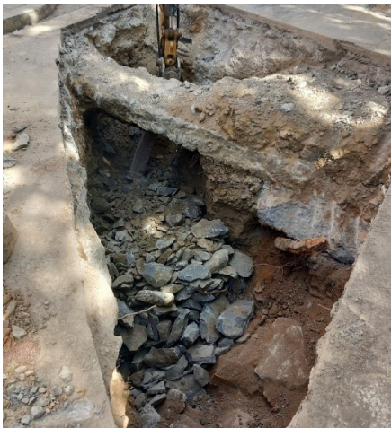
Imatge de la cambra de connexió dels 2 tubs de clavegueram del c/Nou amb el clavegueram de la ctra. de Roda.
